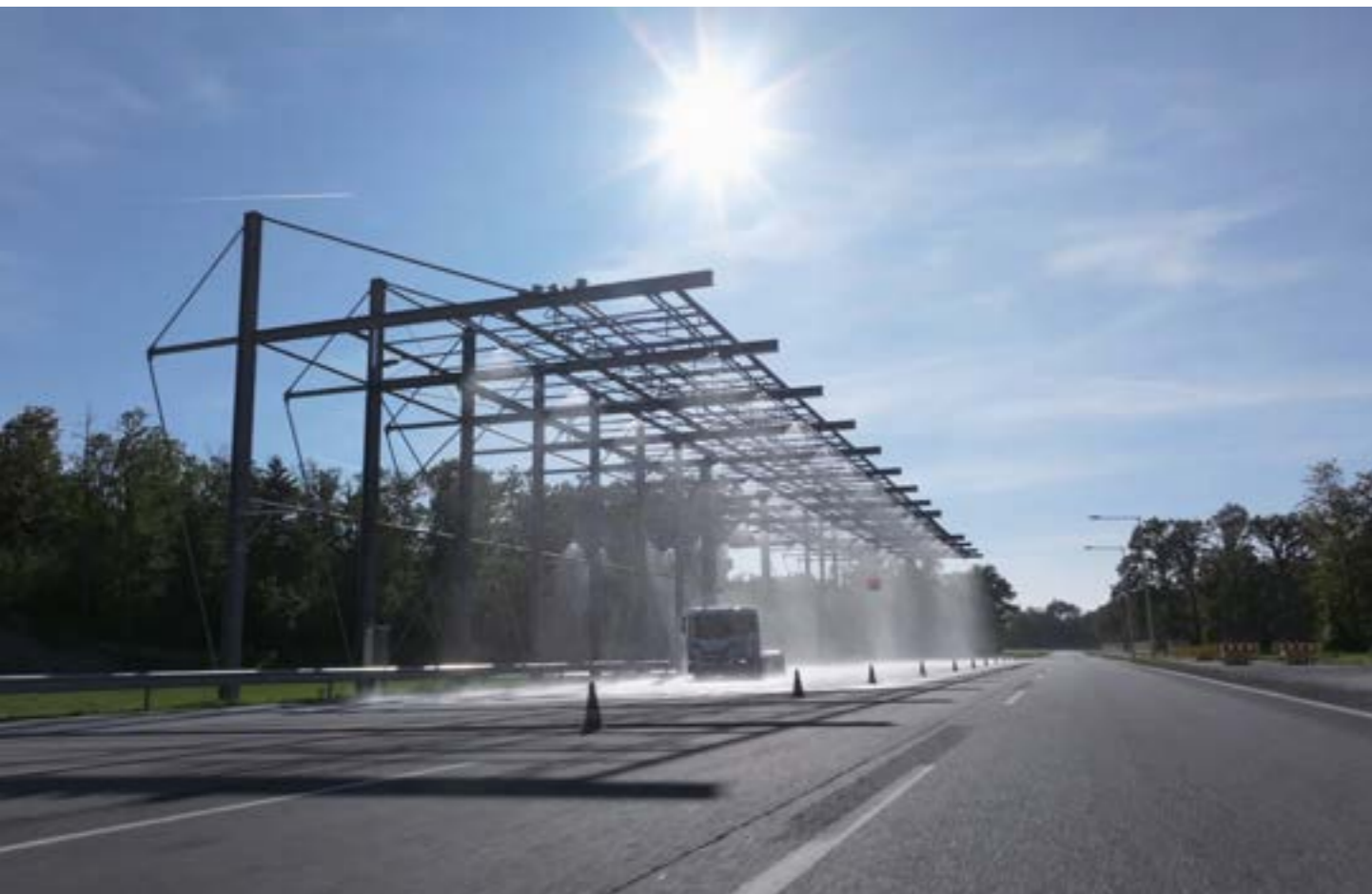
Abbildung 5: Tests unter der Outdoor-Beregnungsanlage im Digitrans Testcenter für automatisiertes Fahren in St. Valentin ©DigiTrans GmbH
